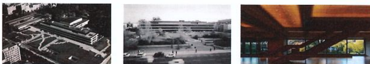
Figura 18 – Fotos do Edifício Sede da Fundação Calouste Gulbenkian, em Lisboa.
