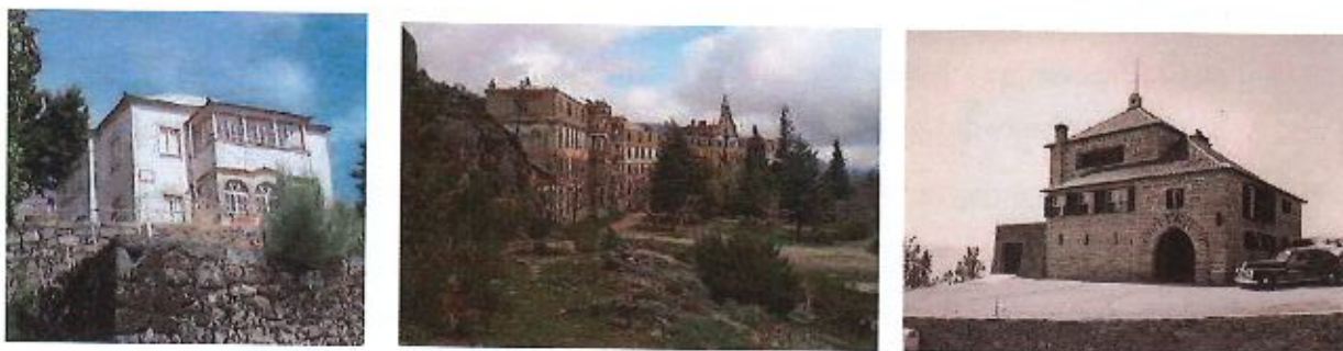
Figura 47 – Imagens do Palacete Aníbal Falcão, do anterior Sanatório dos Ferrovários e da Casa de São Lourenço.
