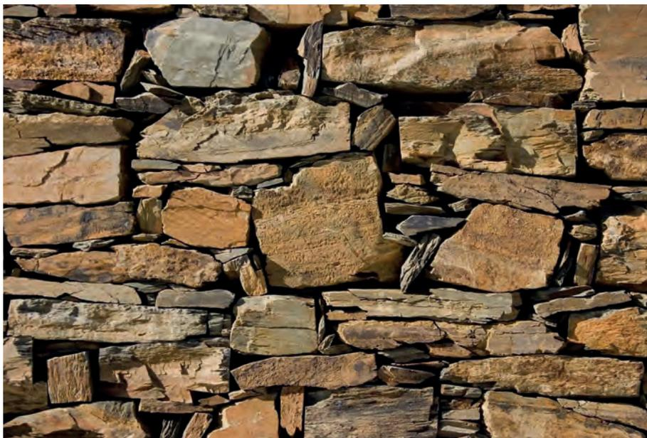
É um saber-fazer ancestral, que consiste numa técnica de construção caracterizada pelo processo de “travação” e encaixe de pedras secas, sem qualquer aglomerante, na forma de laje que constitui a apresentação natural da pedra de xisto. Característico da aldeia da Figueira, utiliza-se tanto na construção de muros para abrigo e refúgio de várias espécies de plantas e animais, como no suporte das margens das ribeiras e de terras de cultivo.
