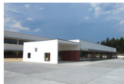
Escola Básica de Aguada de Cima
