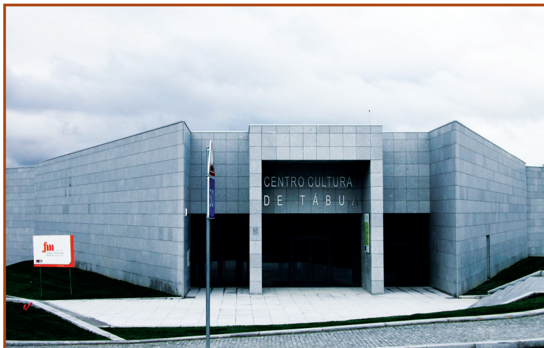
Construção do Centro Cultural de Tábua
