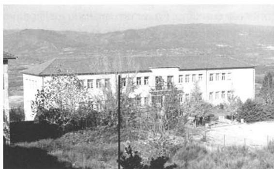
Foto 96 - Edifício chamado “Do Colégio Novo”, construído expressamente para o Externato de Nª Srª da Esperança
