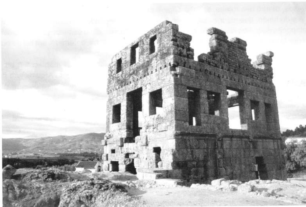
Foto 2 - Belmonte. Torre de Centum Cellas, centro da parte urbana da Villa romana, fortificada
