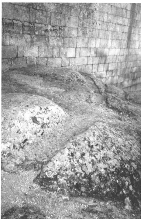
Foto 33A - Alicerces cavados na rocha, junto à janela manuelina
