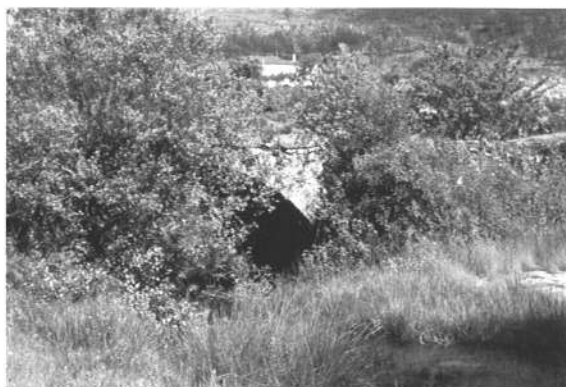
Foto 10 - Ponte romana junto das Quintas do Porto, entre Benespera e Quintas do Monte
