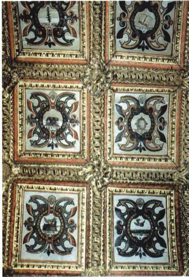
Pormenor 56 do tecto da Capela-Mor – Foto M. Tomás
