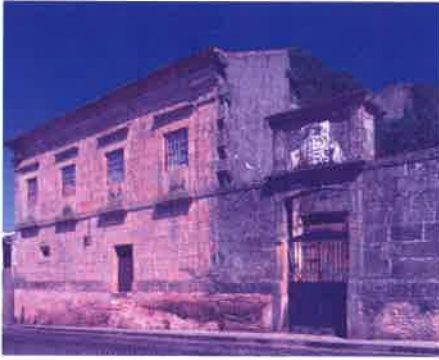
Figura 69: Solar dos Condes de Belmonte
