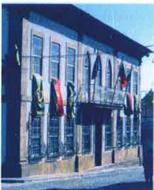
Figura 70: Paços do Concelho/Edifício da Câmara
