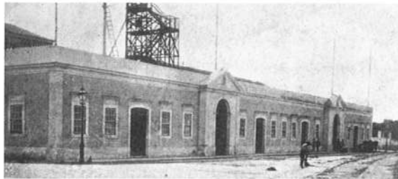
Fig. 26 - Fachada principal do imponente edifício da resinagem.
