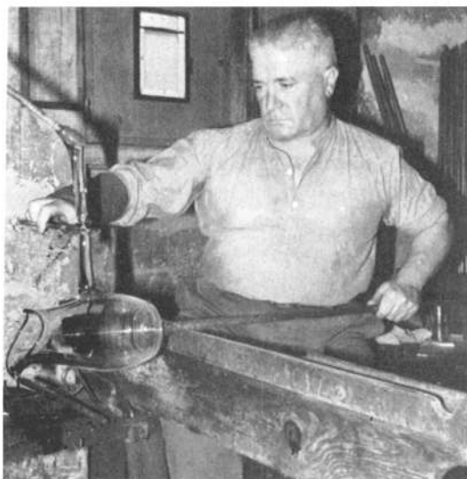
Fig. 77 - Cristalaria, fase do fabrico manual: colocação da asa num jarro.
