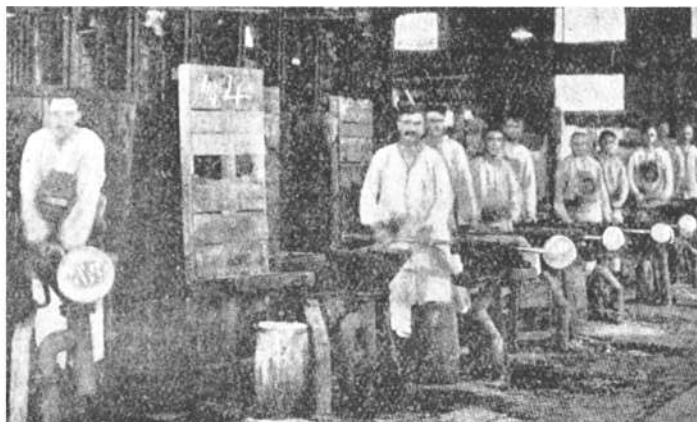
Fig. 86 - fabrico manual da vidraça: formação da bola.
