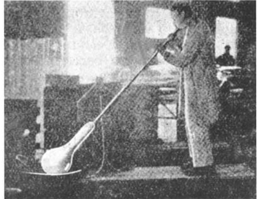
Fig. 88 - Fabrico manual de vidraça: molde de acabar.
