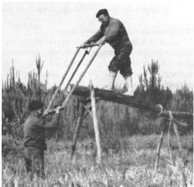
Fig. 31 - A operação de serragem tal como se fez durante muitos anos, vendo-se os serradores manuais, a falca, a "burra" e a serra. Pensa-se que na Mata existiram mais de 200 destes serradores.
