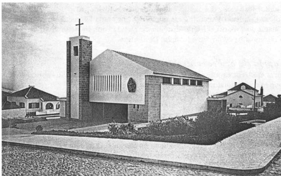
Fig. 129 - capela actual de S. Pedro de Moel.
