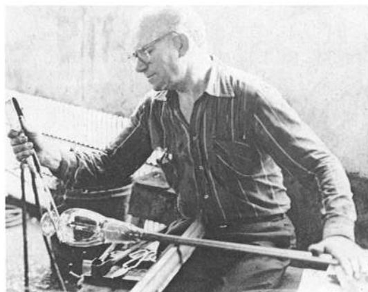
Fig. 77 - Cristalaria, fase do fabrico manual: colocação da asa num jarro.
