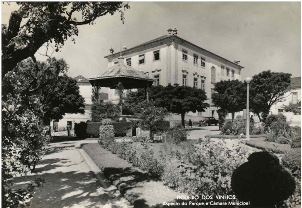
Câmara Municipal (Figueiró dos Vinhos)
