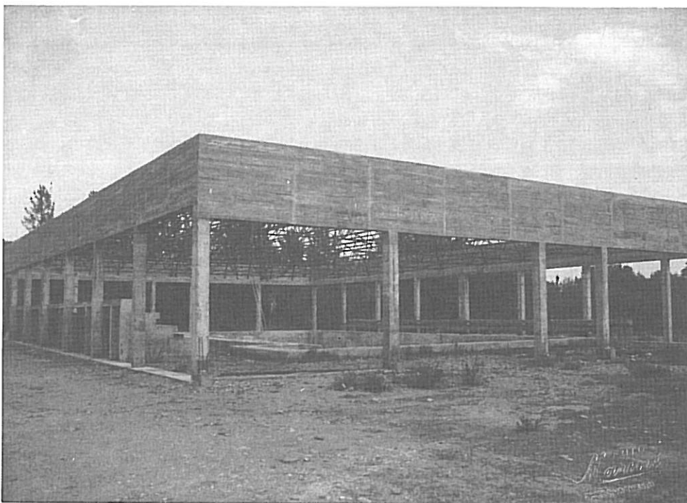
Foto 56 — As Piscinas Municipais em fase de construção.
