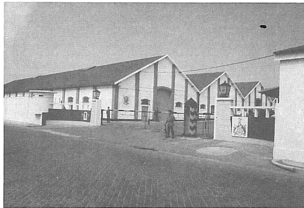
Foto 48 — Batalhão de Serviço de Material.
