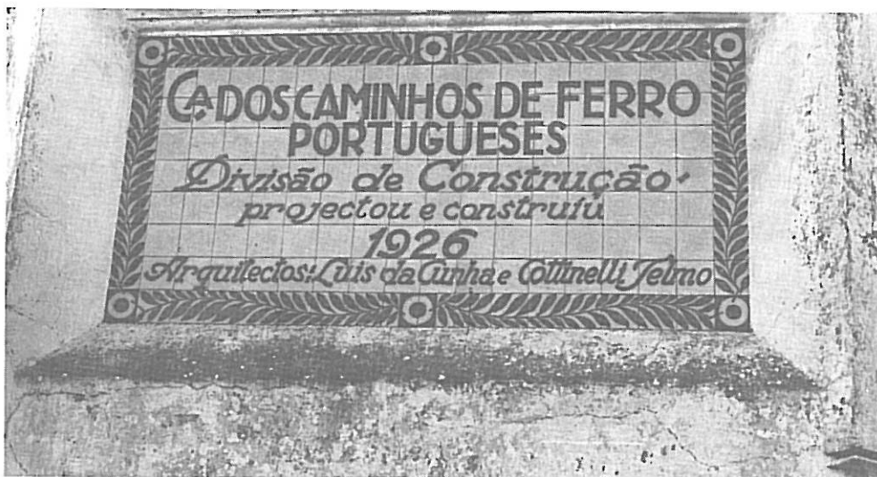
Foto 26 — Arquitectos do Bairro Camões.
