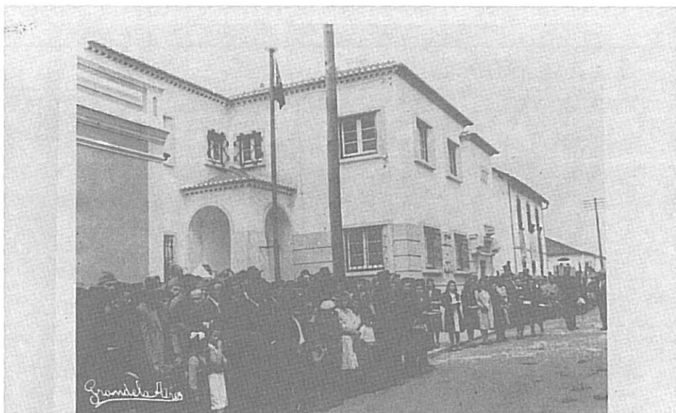
Foto 49 — Edifício do Posto da Polícia de Segurança Pública.
