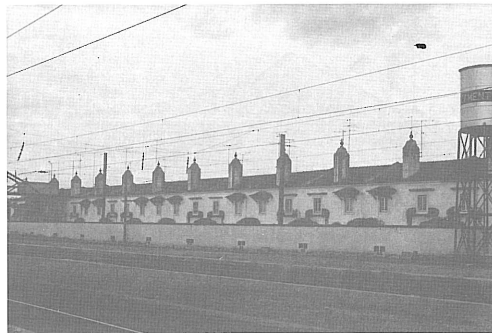
Foto 52 — Bairro Social Ferroviário da C.P..
