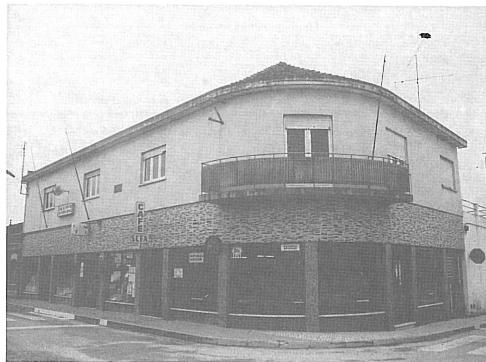
Foto 46 — Edifício da Sede da Sociedade Cooperativa de Crédito e Consumo dos Ferroviários e Aderentes (S.C.F.A.)
