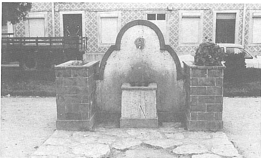
Foto 9 — Fontanário do Bairro Novo - 1943. Actualmente no Largo 24 de Novembro, conhecido como o Largo do Poço Novo.
