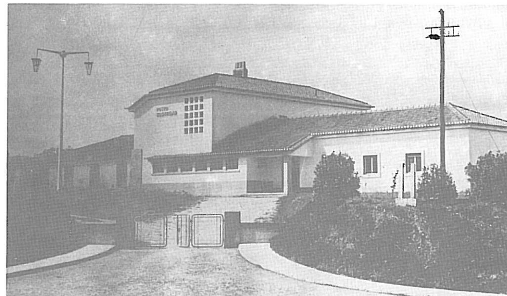
Foto 31 — Hospital da Misericórdia no Entroncamento, inaugurado a 27 de Novembro de 1955.
