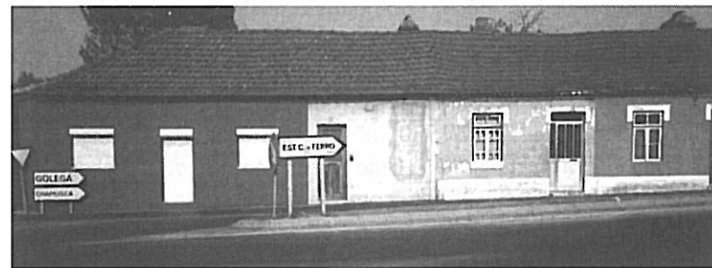
Casas do Lugar da Ponte da Pedra.
