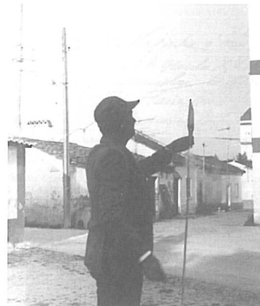
1982: O foguete que deu início às obras de reconstrução da Capela (1).
