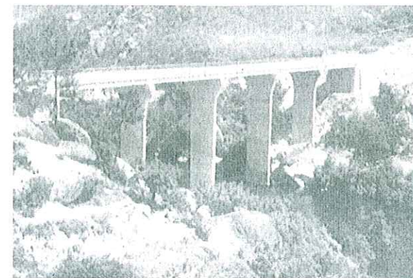
CALDEIRÃO — Ponte Eng.º Rui Sanches, sobre o Mondego entre Tábua e Carregal do Sal
