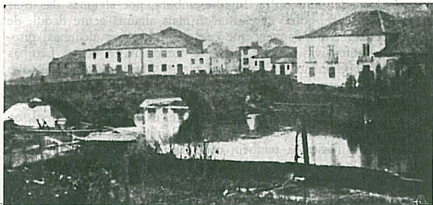
Cais das Laranjeiras. O lugar de Além da Ponte. A direita, Casa de Miguel Henriques de Castro (Casa da Ponte).
