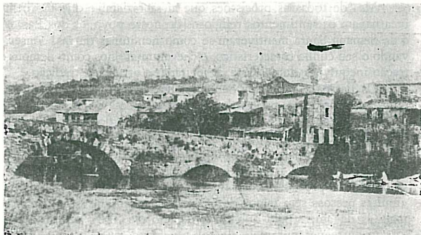
[A velha ponte foi substituída em 1882. Com a demolição das casas da Rua da Ponte e do Barril e o alargamento da Praça Nova alterou-se a fisionomia do velho burgo].
