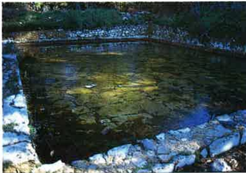
38 Reservatório de abastecimento de água aos tabuleiros de congelação.
