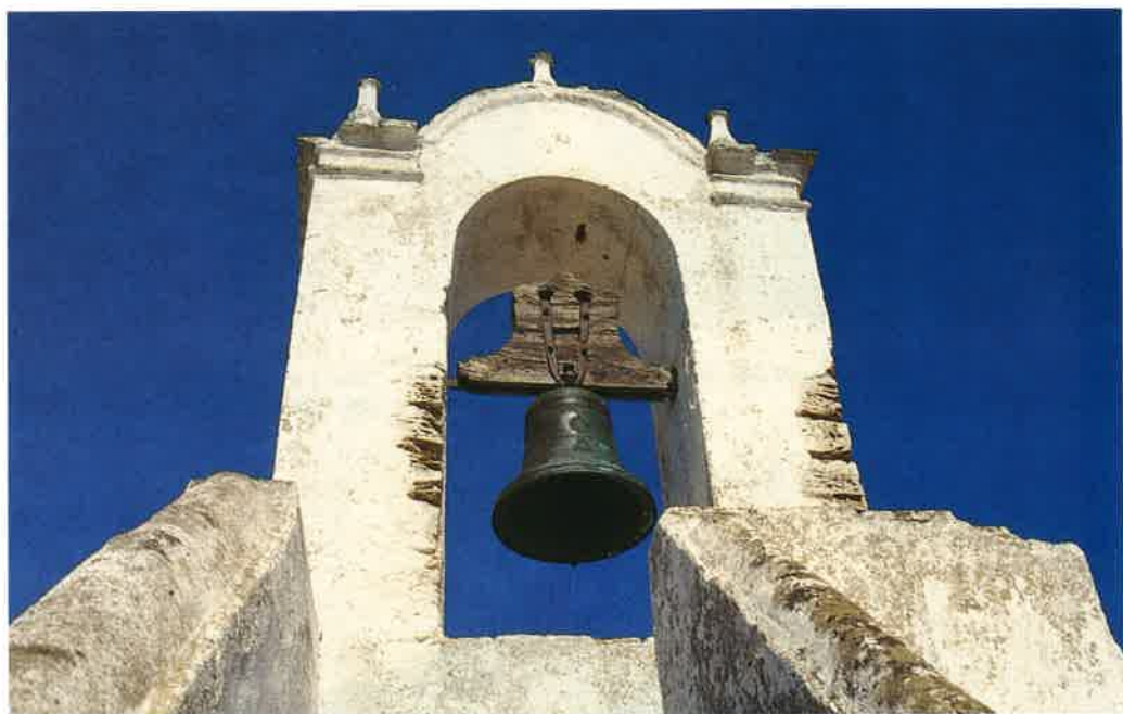
64 Torre sineira da igreja de S. Simão, Vermelha.
