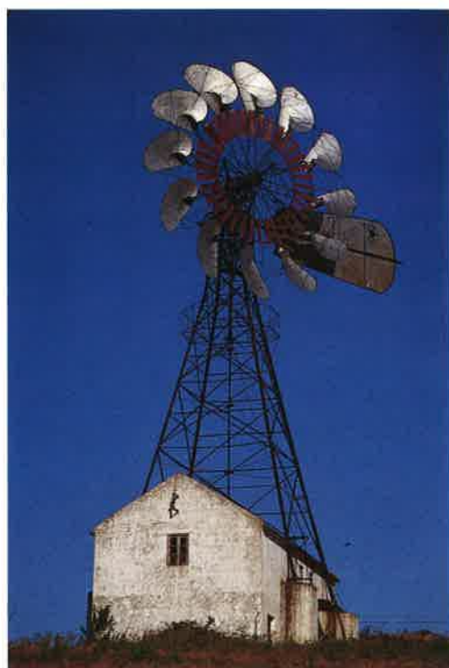
114 Moinbo de armação metálica na sede de concelho.
