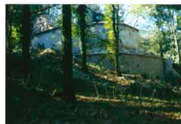
Aspecto final após reabilitação – Vista de conjunto Norte.
