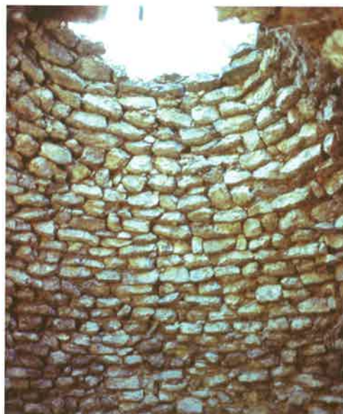
Dispositivo em pedra e seixos de uma das geleiras do massivo de Étoile, comuna de Mimet. Vista da pedra angular. Construção do século XVII.
