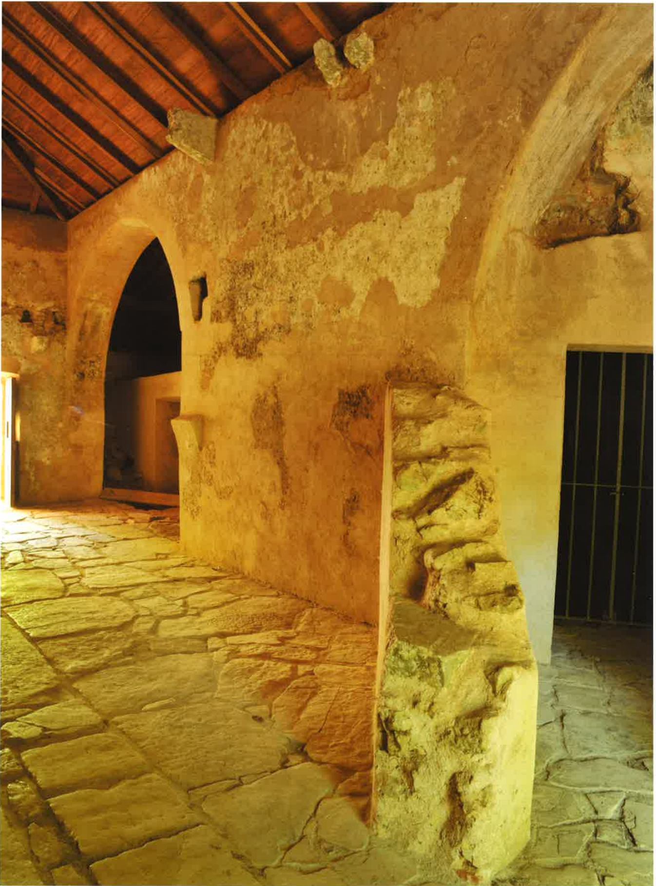
Interior do Edifício dos Silos. 2009. Henrique Ruas IGESPAR
