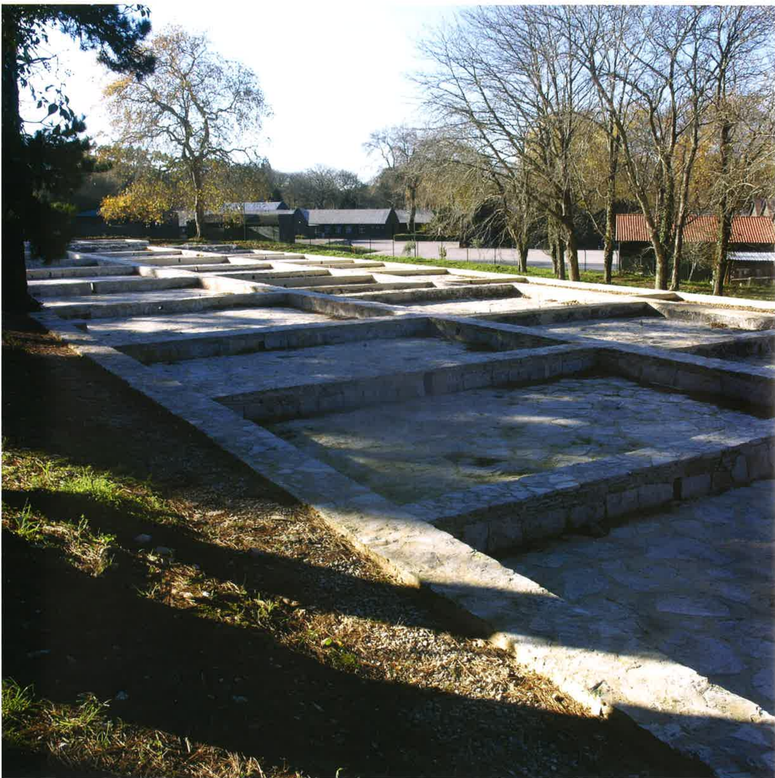
Fábrica de neve, tanques de congelação ou geleiras, após restauro. 2008. Câmara Municipal do Cadaval
