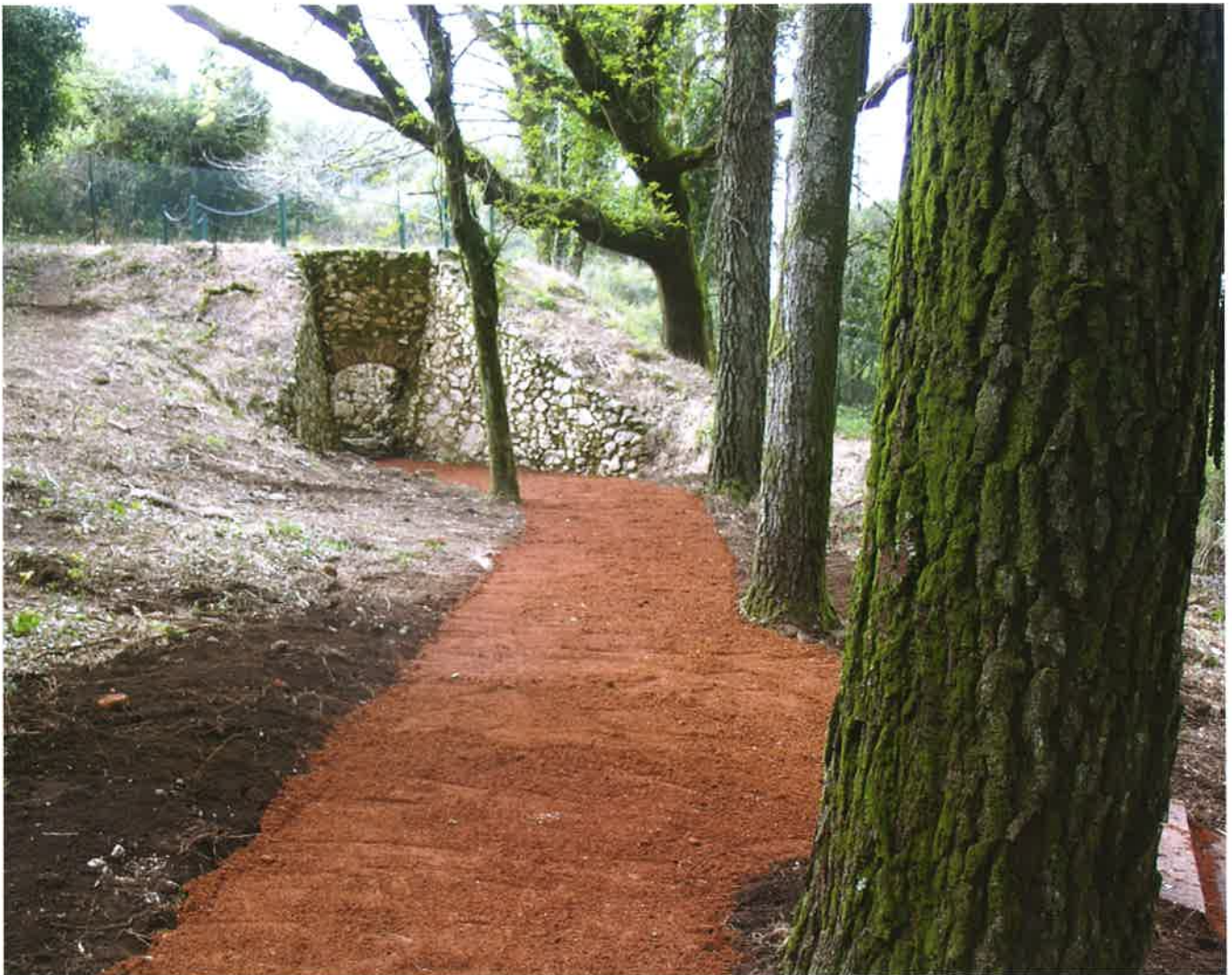
Acesso ao forno de cal. 2009. Câmara Municipal do Cadaval
