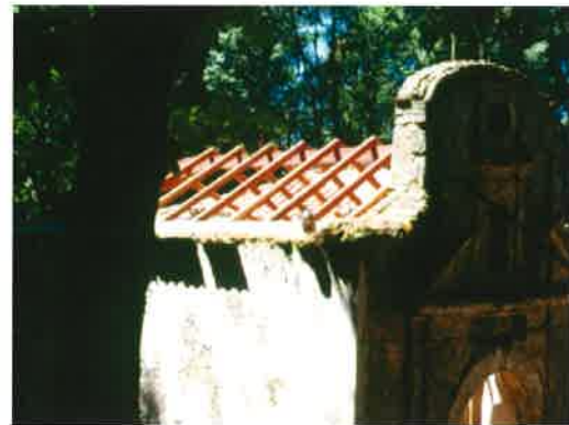
Ensaio de armação de madeira.
