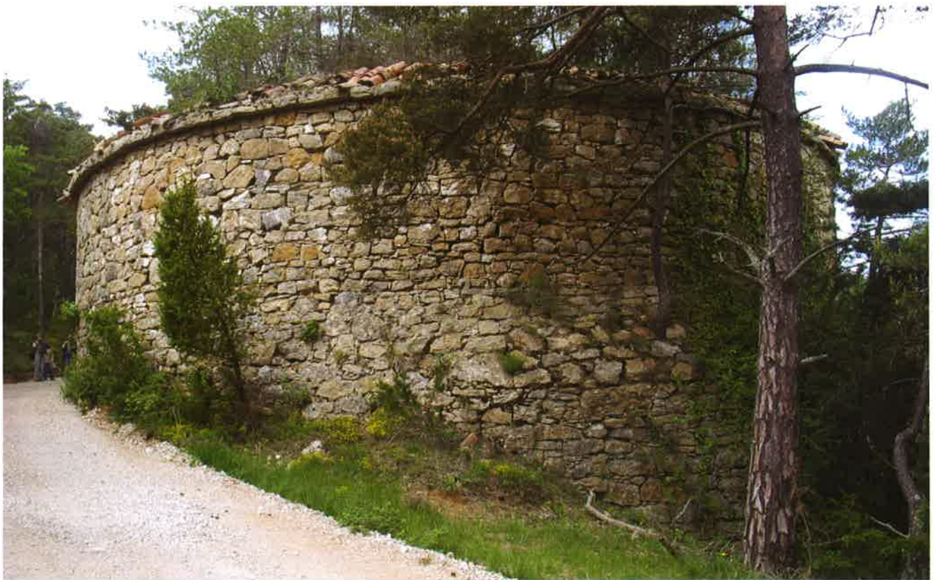
Uma das geleiras da Sainte-Baume (Provença) no distrito de Ombre. Dispositivo em pedra calcária, tecto coberto de telhas, cornija em lousas calcárias. Reestruturação do local no século XIX.
