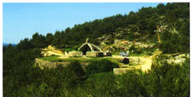
Cava Gran (Agres) Se aprecia los arcos que sostenían la cubierta y la gran plataforma que envuelve el pozo para asegurar la conservación de la nieve.
