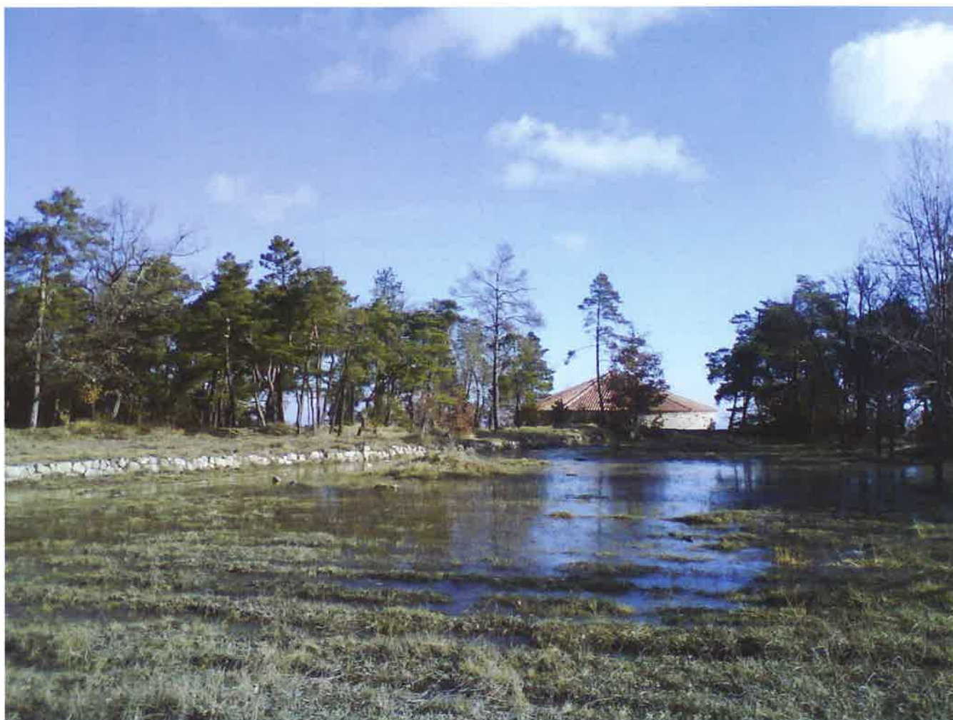
O último reservatório construído na Sainte-Baume (anos 1870-1880) e os seus contentores de gelo, que foram parcialmente inundados e congelados. Fevereiro de 2009.
