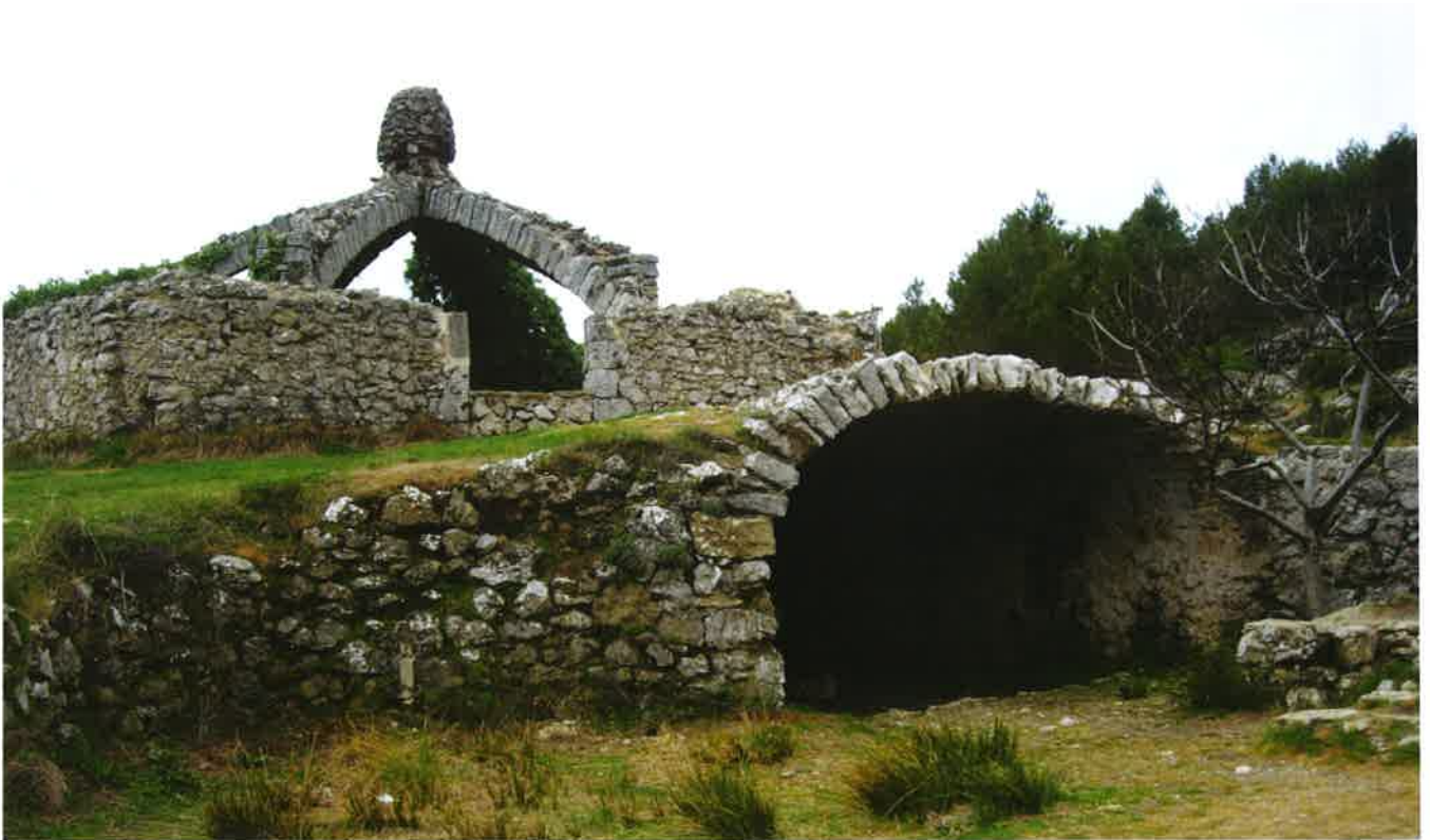
Cava Gran (Agres) entrada al túnel que conduce a mitad altura del pozo interior.
