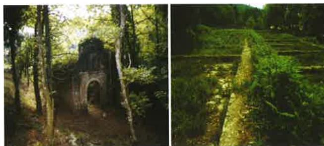
Edifício dos poços de armazenamento do gelo e tanques de congelamento da água, antes da intervenção. 1987, ECTV
