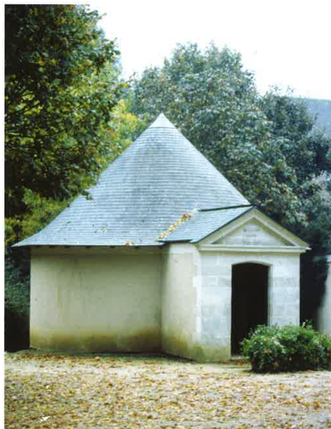
A geleira do Jardim do fim do mundo na vizinhança das muralhas da cidade de Château-Gontier em Mayenne. Construção em alvenaria de pedra, século XVIII.
