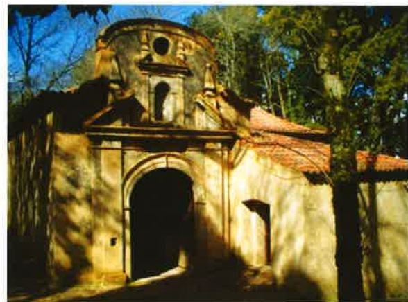
Área de armazenamento e expedição do gelo. Fachada principal. 2004.
