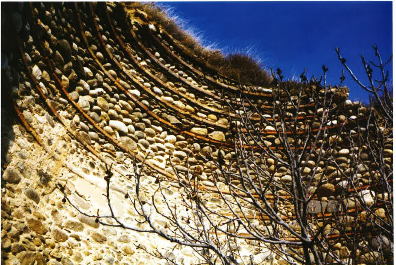
Dispositivo em pedra, tijolo e seixos de uma das geleiras de Roussillon, comuna de Millars. Construção do século XVII.
