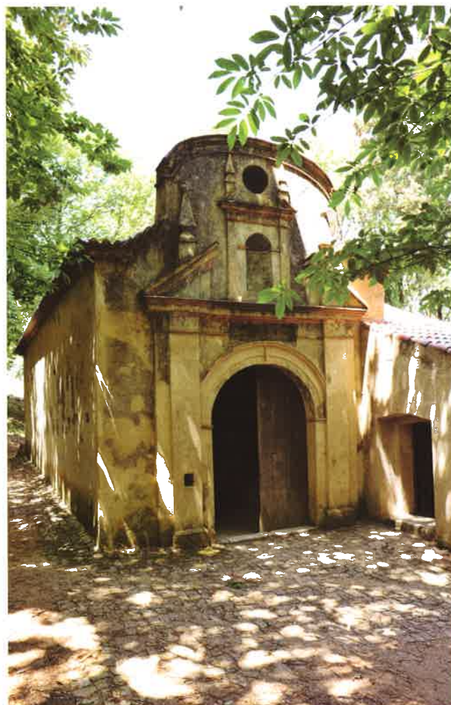
Fachada principal da entrada para os silos. 2009. Henrique Ruas IGESPAR
