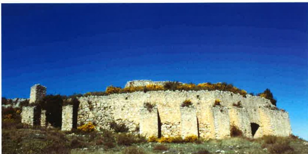
Cava de Don Miguel (Bocairent) se aprecian los contrafuertes que refuerzan el muro perimetral; la entrada de uno de los túneles de acceso al pozo y, a la izquierda, la chimenea de la estancia para los trabajadores de la nieve.
