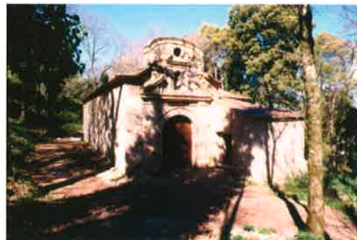
Aspecto final após reabilitação. Alçado Nascente e Sul.
