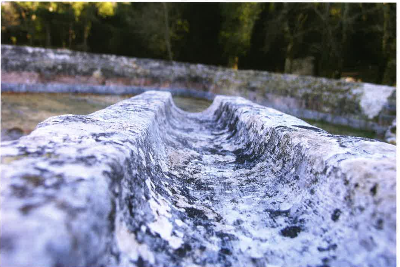
Caleira de alimentação do tanque. Fábrica de neve de Montejunto. Câmara Municipal do Cadaval
