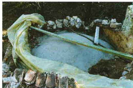
Re-fechamento de fissuração pelo extradorso da abóbada do silo exterior Nascente.
