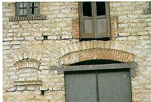
Fig. 13 - Protecção dos lintéis com arcos de tijolo burro e adobe.
