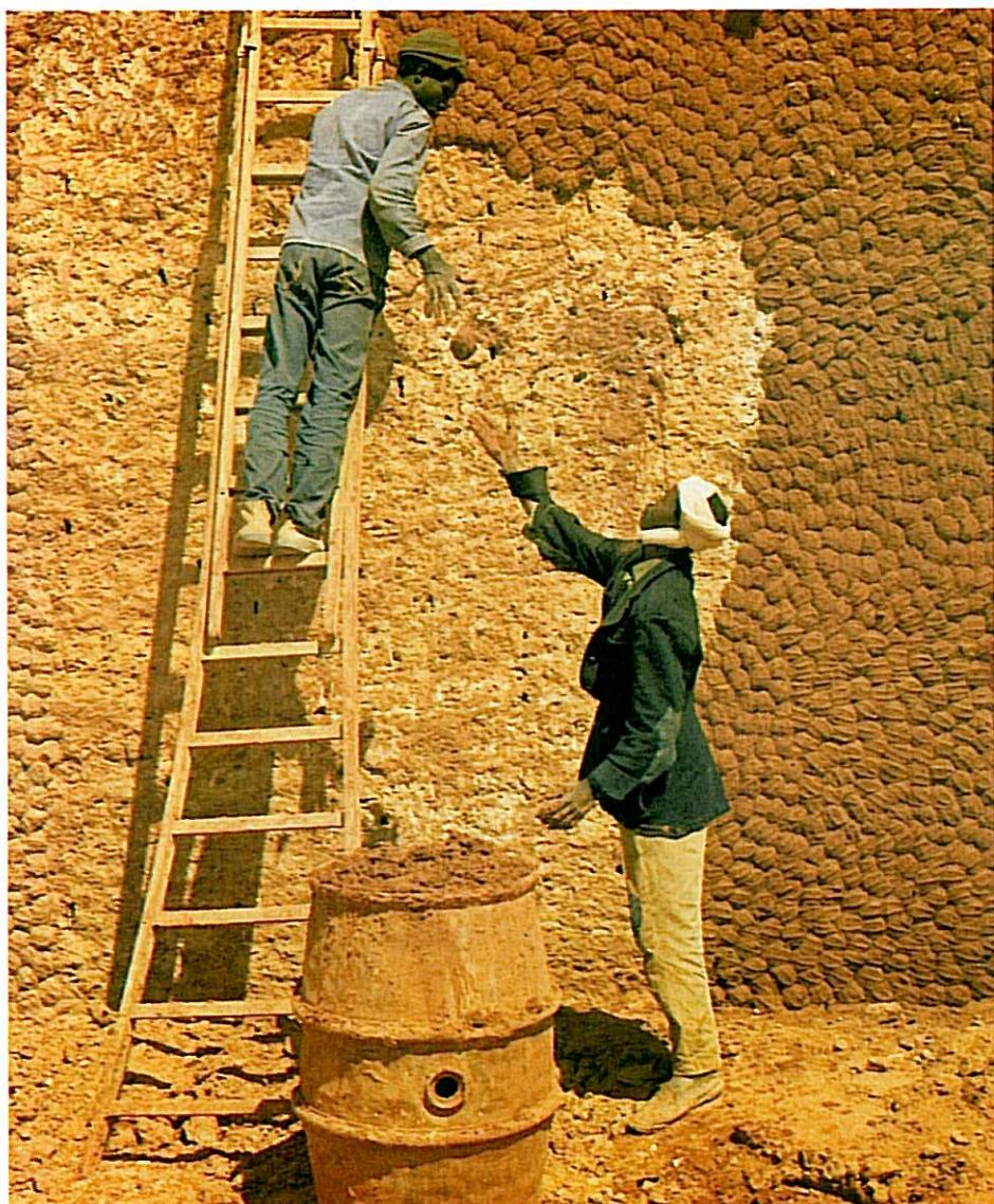
Fig. 21 - Revestimento de parede no Sara Argelino, 1979.
