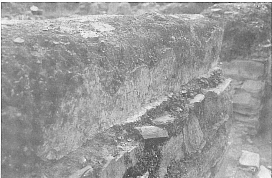
Fig. 36 - Mértola. Parede em taipa acima de 70 cm do solo.
