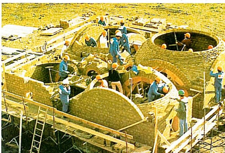
Fig. 48 - Construção experimental realizada em 24 horas no campus da Universidade de Grenoble. CRATerre, 1987.
