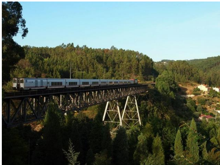
Imagem 7. Ponte das Várzeas, Mealhada - Infraestrutura ferroviária da Linha da Beira Alta
