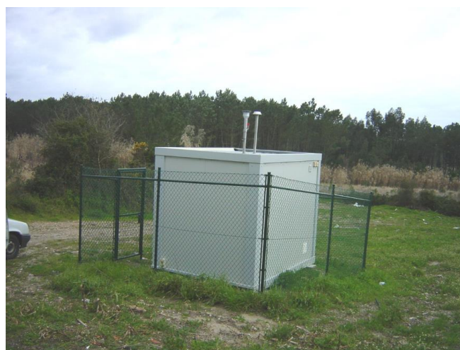
Estação da Qualidade do Ar da Ervedeira
