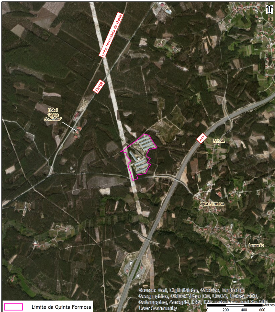
Figura 1 - Imagem aérea da área de implantação e envolvente do projeto de ampliação da Instalação Avícola da Quinta Formosa.
