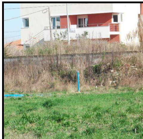
Figura 4: Tubo piezométrico instalado.
