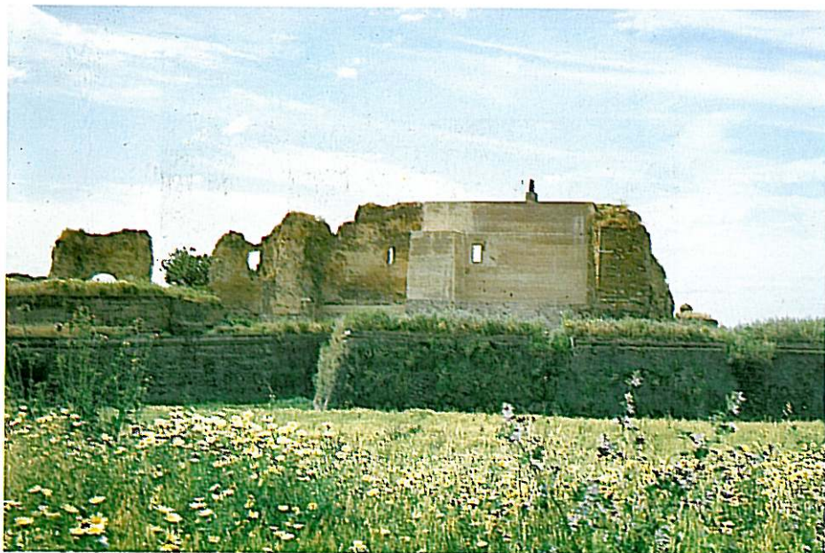
Fig. 14 - Juromenha - Recuperação de estrutura.
