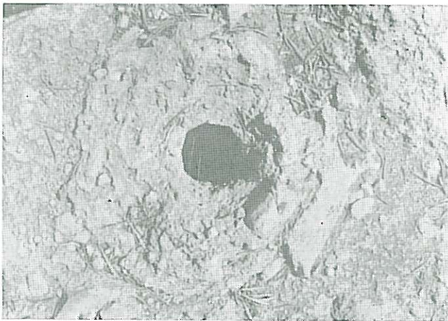
Fig. 9 - Castelo de Salir. Pormenor de um buraco de taipal.
